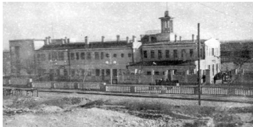
Томатоварочный завод станицы Цимлянской.
